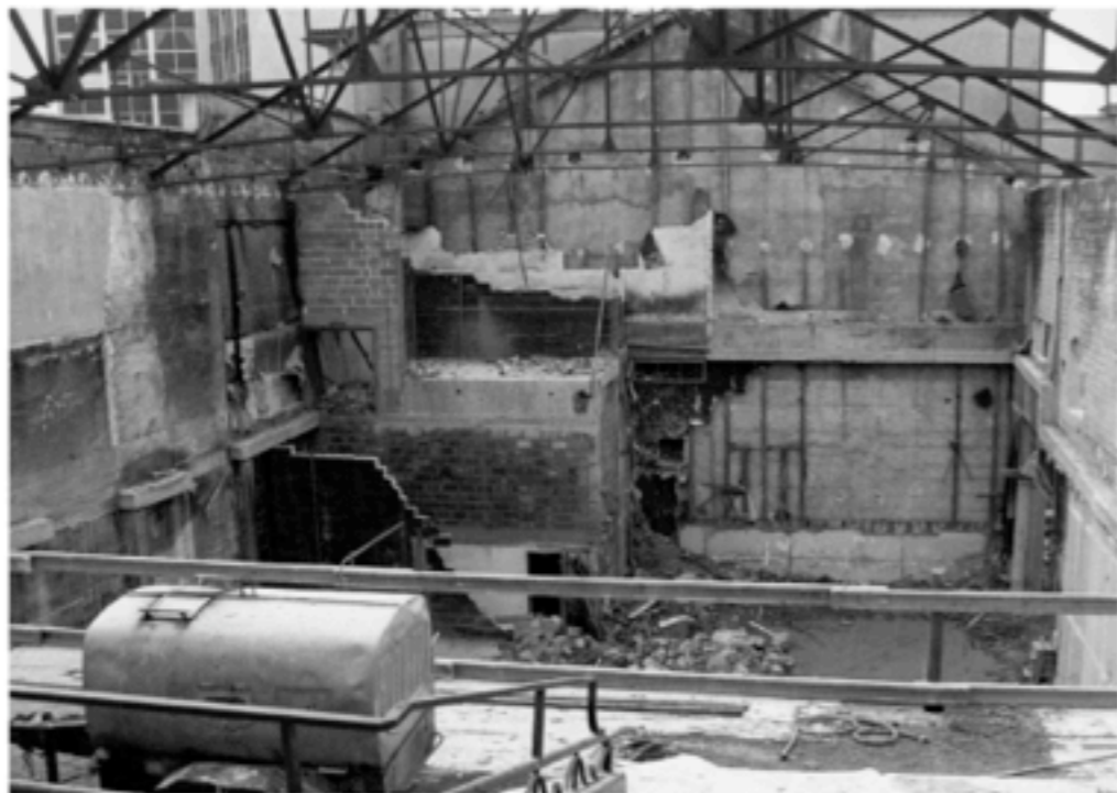
démolitions (vue vers la scène)
