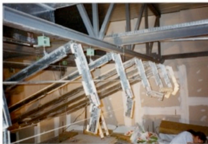
chantier : détail des ossatures de plafond
