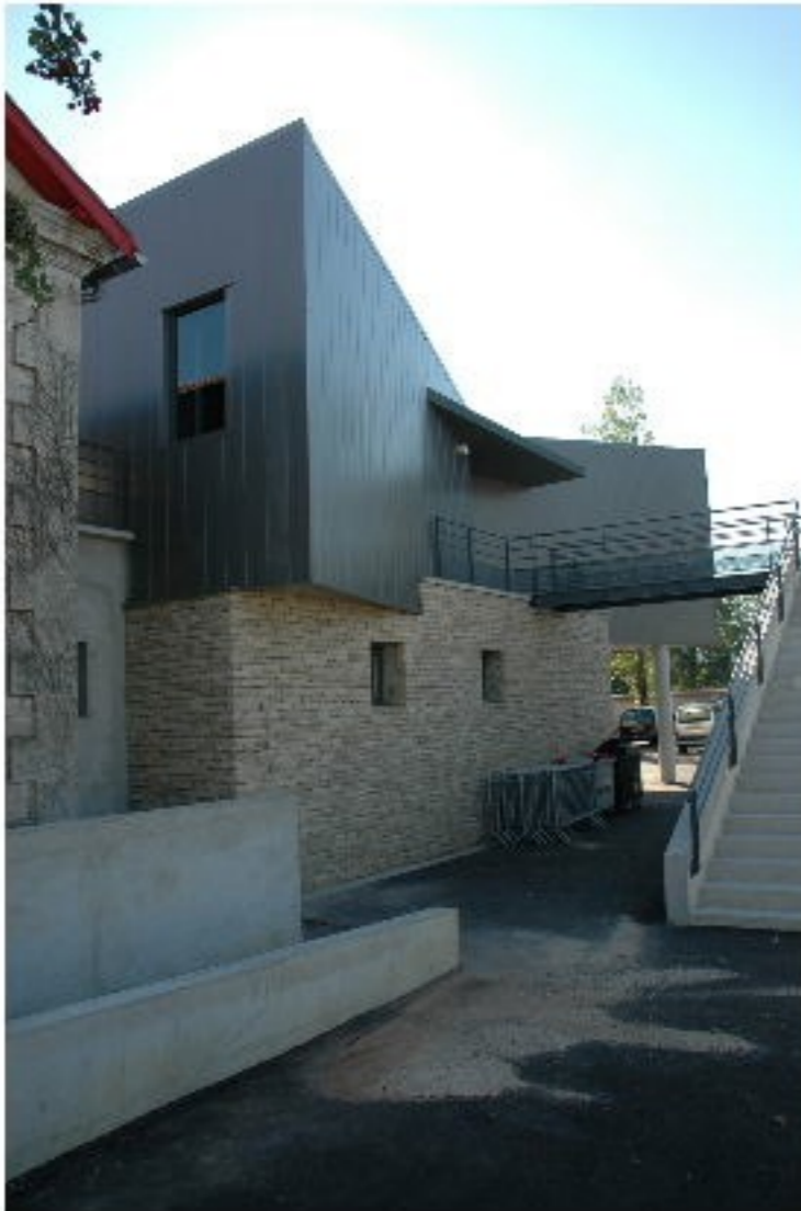
façade accès technique
