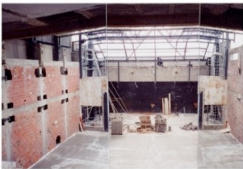
chantier : vue vers la scène
