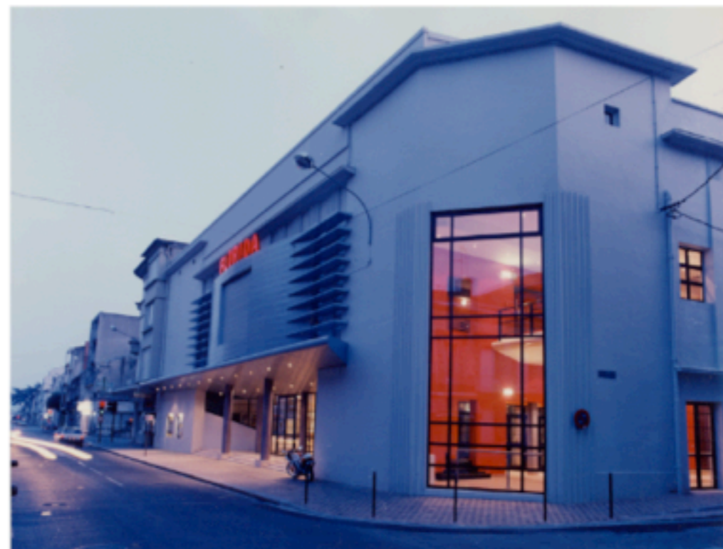
façade boulevard Carnot
