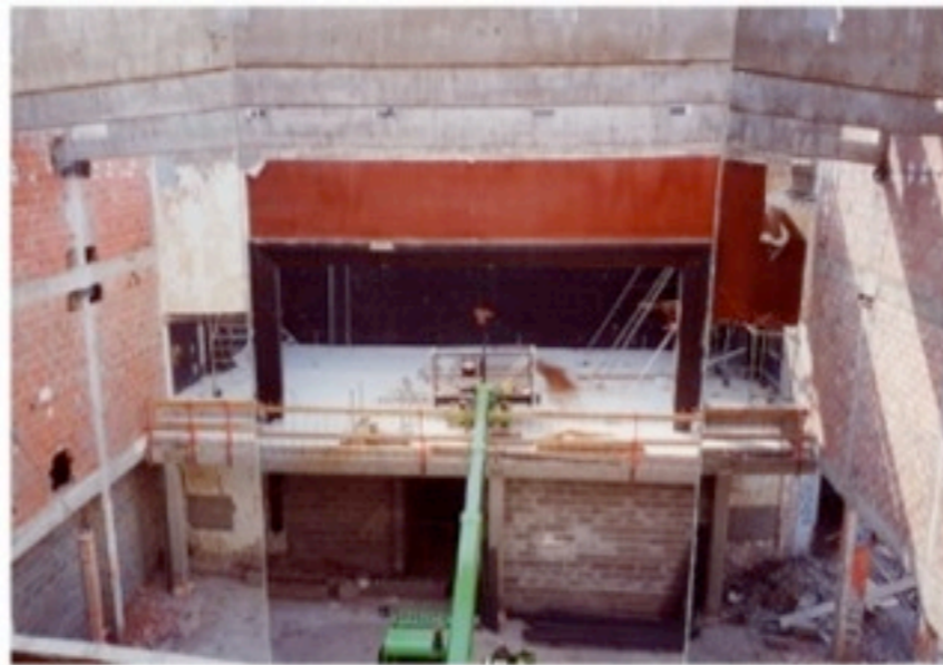
chantier : vue vers la scène et les studios
