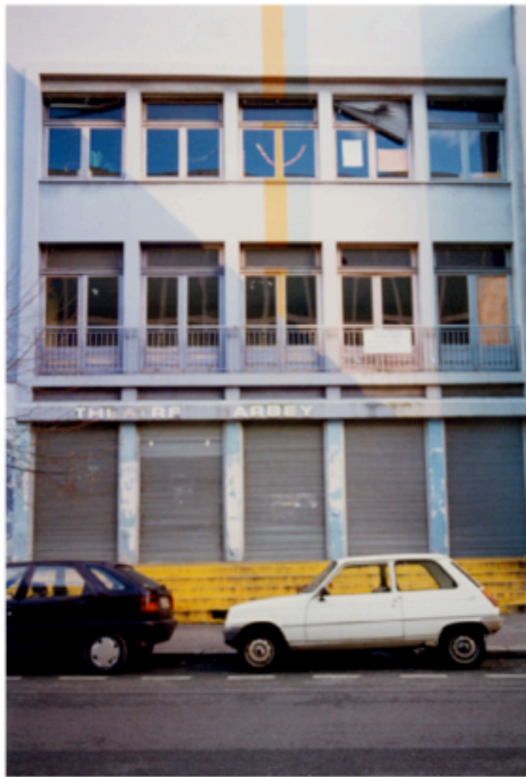
avant travaux : façade sur Cours Barbey
