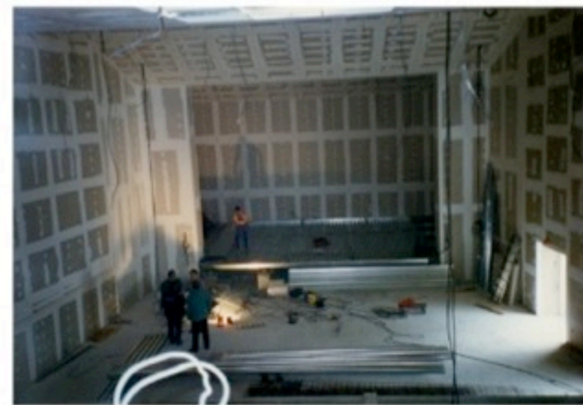
chantier : vue vers la scène (doublages)
