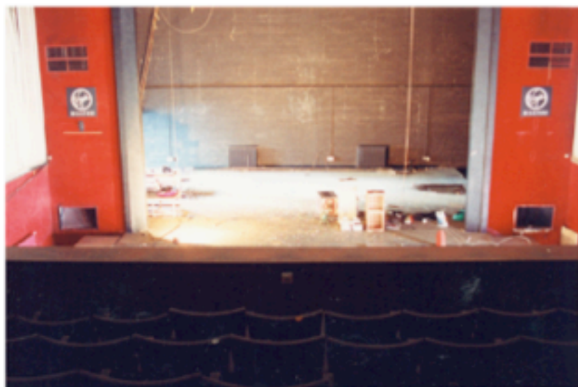
avant travaux : scène ( vue de la salle )
