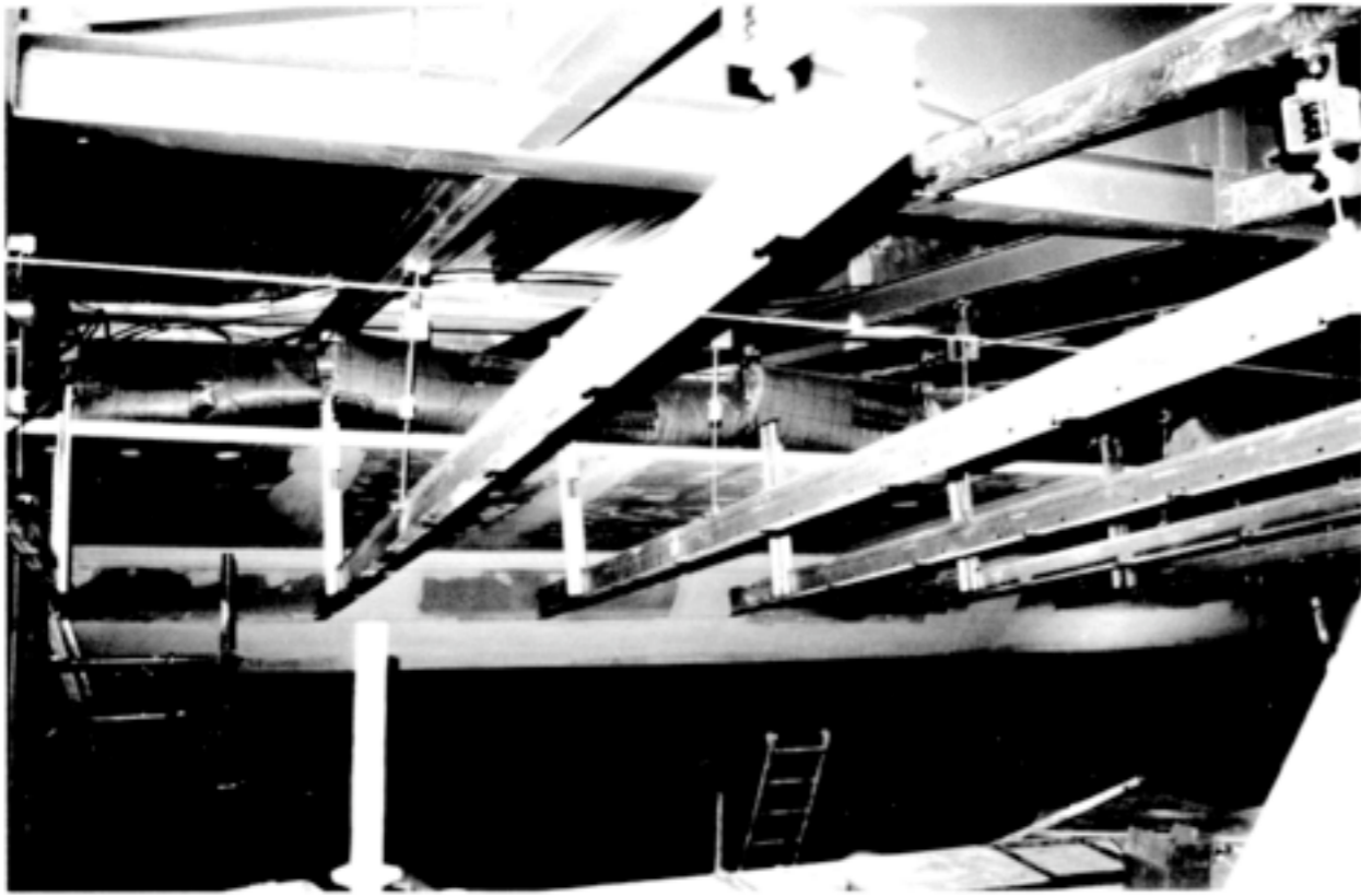
exécution du plafond acoustique : détail des ressorts
