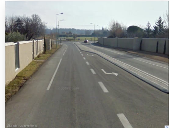
Mur de clôture - Traitement de type « urbain »
