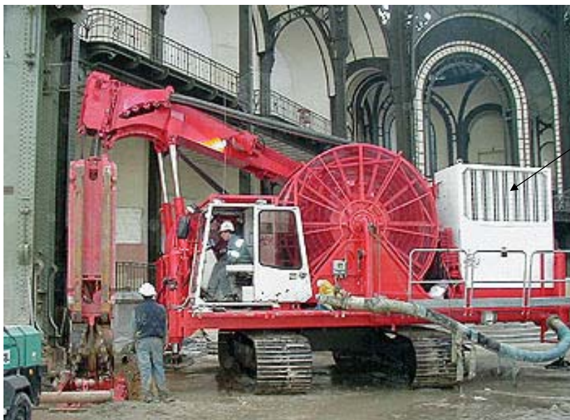
Hydrofraise HC03 (paroi moulées & barettes)
